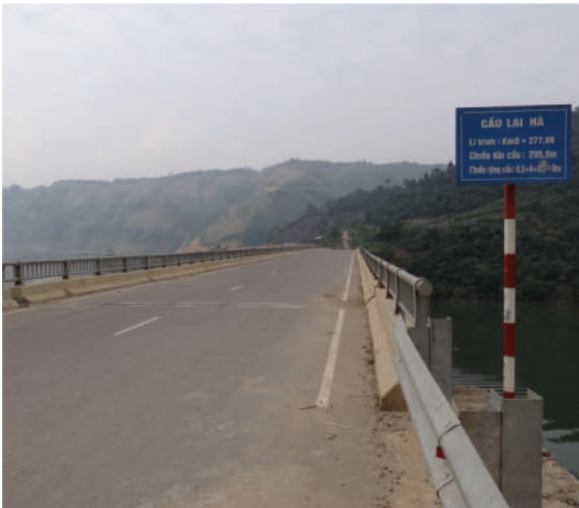
Cầu Lai Hà - Lai Châu
